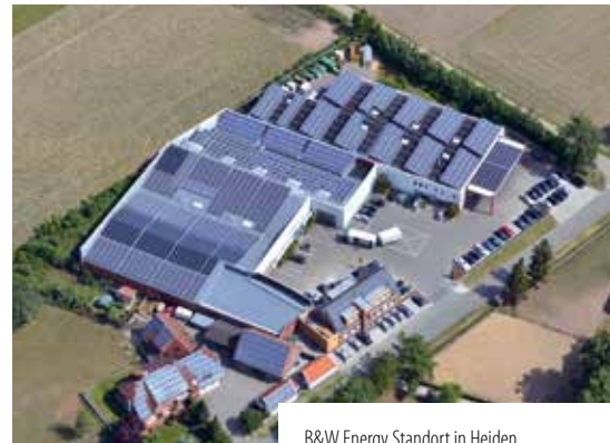
B&W Energy Standort in Heiden
