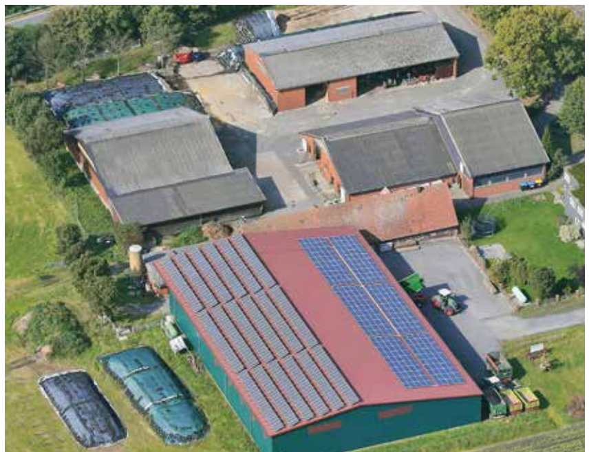
Landwirtschaftlicher Betrieb in Marl, 150 kWp, Inbetriebnahme 2009 & 2013 (2 Anlagen)
