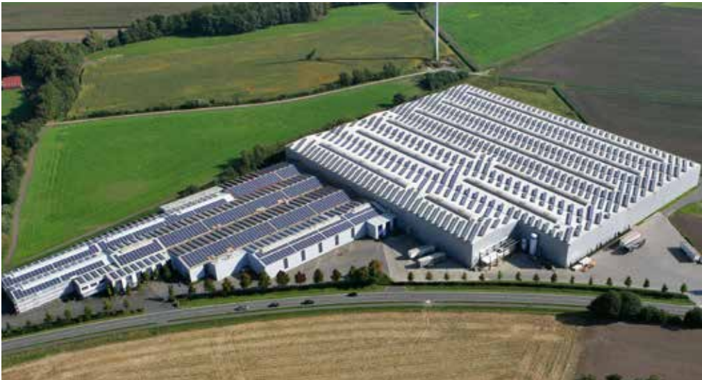
Metallbetrieb in Ahaus, 848 kWp, Inbetriebnahme 2014
