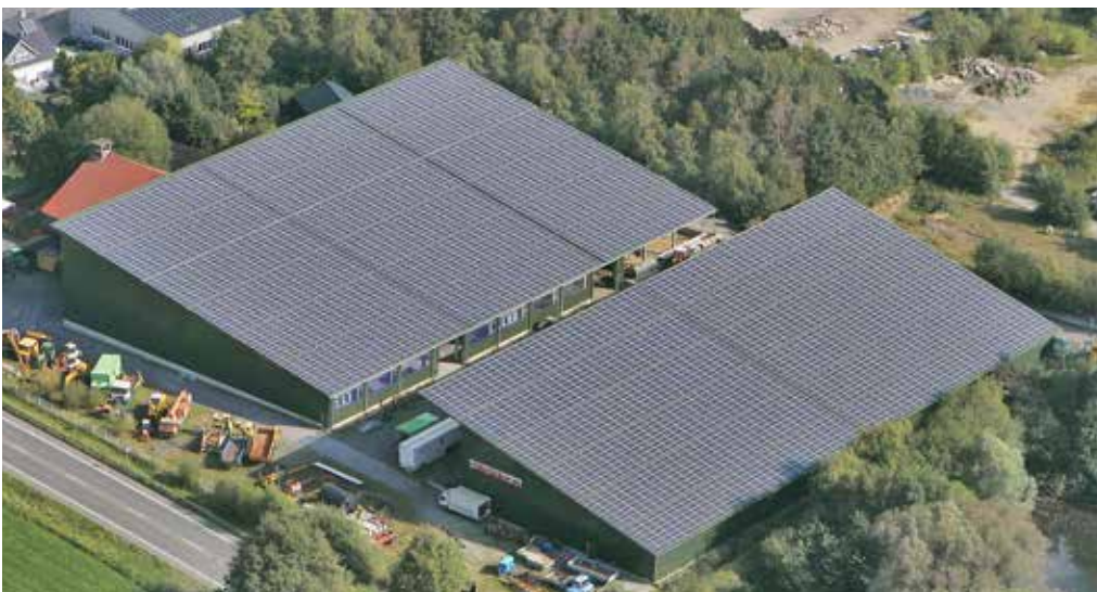
Gewerbehallen in Reken, 618,5 kWp, Inbetriebnahme 2014
