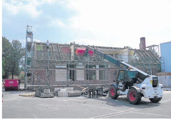
Im Juni konnte der Abriss beginnen.
